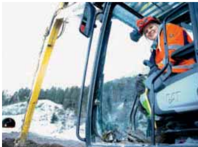
Overgang Mona Seljeset startet på idrettslinja, med kjapp overgang til flerårig maskinførerlærling hos K. A. Aurstad AS, her i arbeid på E69 Kvivsvegen.
