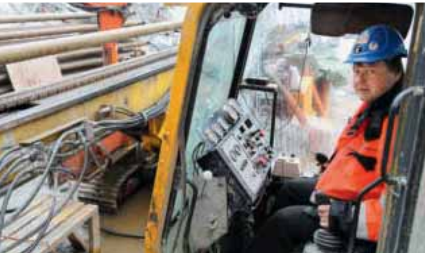
Borerigg Entreprenørservices anleggsleder Harald Solheim prøvesitter Hütte-boreriggen som ble brukt til å lage pilothullet.
