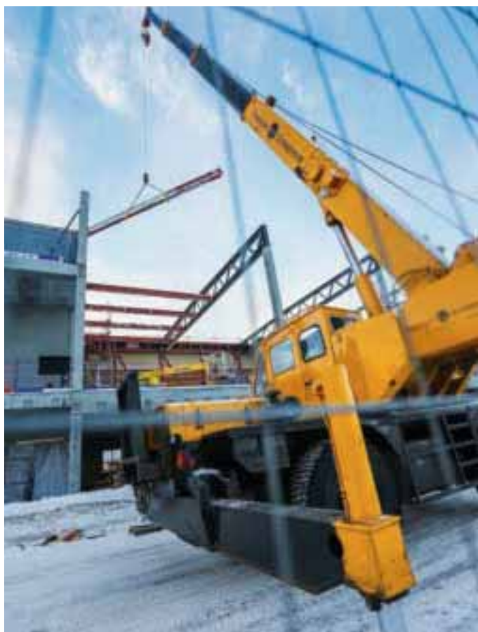
ETTERSPURT Kato mobilkranen er etterspurt i lokalmarkedet. Her i aksjon på Vardøs kommende kommunale flerbrukshus.
