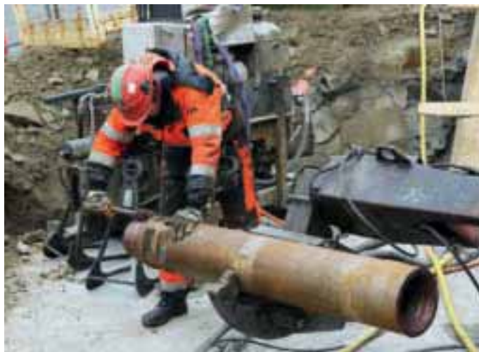
Smøring Operatør Bernt Knudsen smører gjengene i borerøret før det mates inn i boreriggen og festes til borestrengen.
