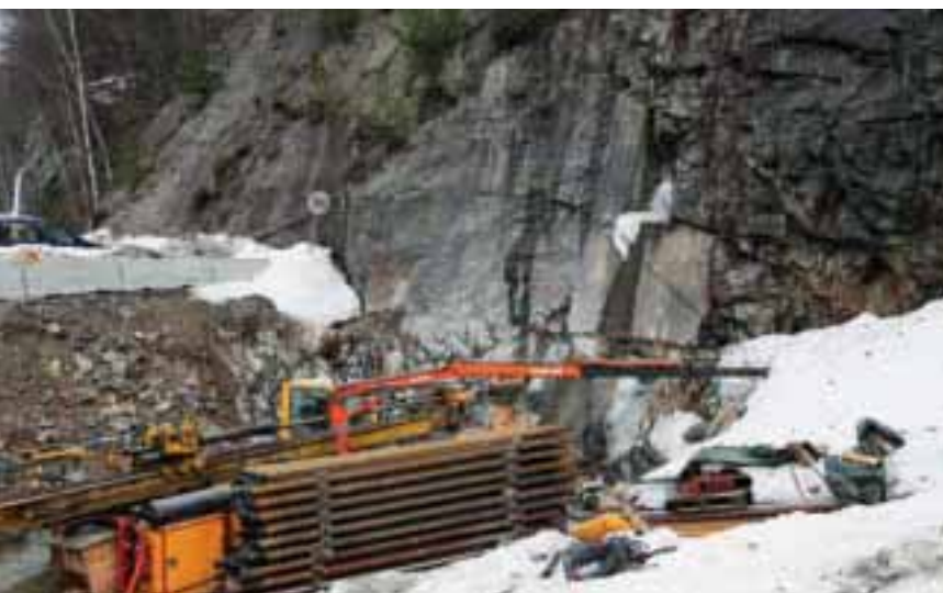
Pilotrør Her nede ved veien som grenser til veien Otra, står Hütte-boreriggen og alle rørene som ble brukt til å lage pilothullet.
