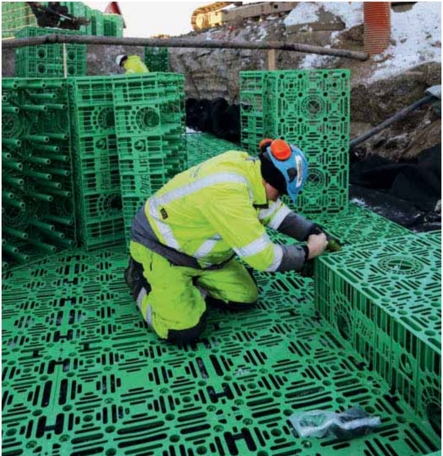
Finstabling Kassene stables og festes sammen. Her er Petter Bredesen fra Romerike Maskin i aksjon.
