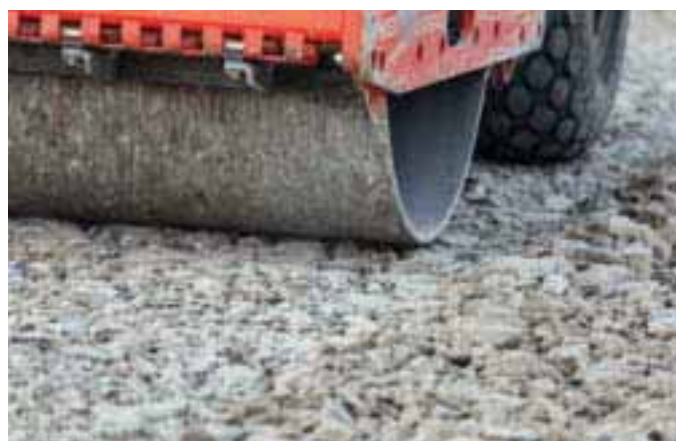
DOKUMENTASJON Vibro-målingen viser hvordan det står til under valsen. GPSen stedfester målingene. Sammen er de dynamitt i dokumentasjonsarbeidet.
