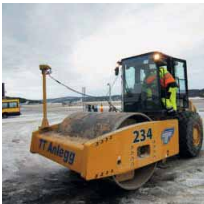
TEGN Venn deg til å se GPS-antenner på valsen. (Foto: Sitech AS)
