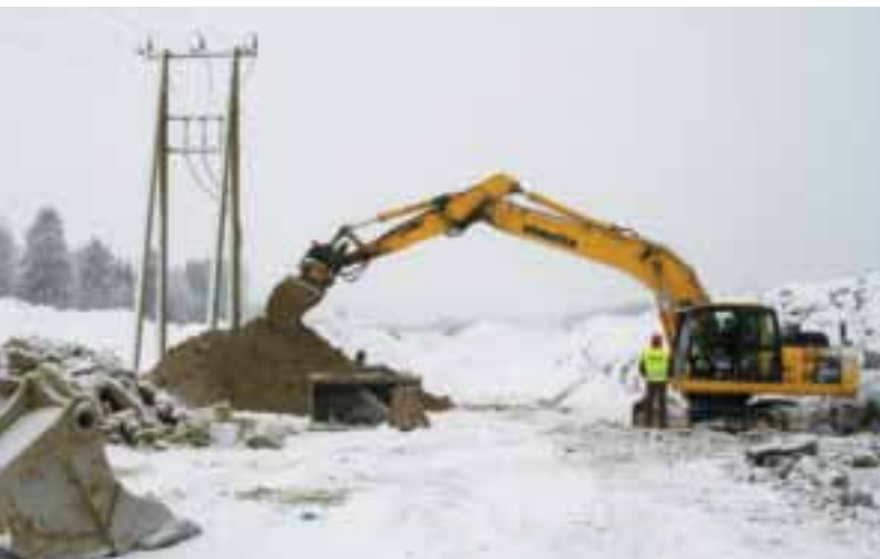
Utleid Maskinfører Anders Larsen med Veflens Komatsu 290 på utleie til Veidekke sørger for omlegging av hovedvannledningen i anleggsområdet.
