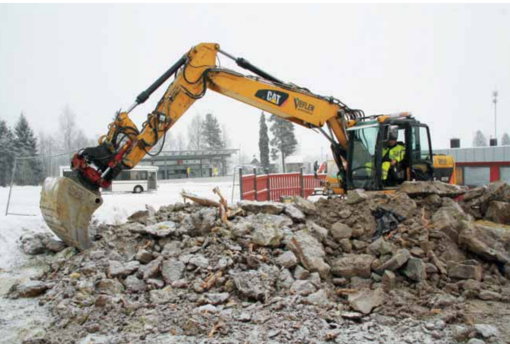
Mer riggplass Maskinfører Bjørn Vangen i full gang med grunnarbeidene for utvidelse av Veidekkes stedlige kontor- og mannskapsrigg.
