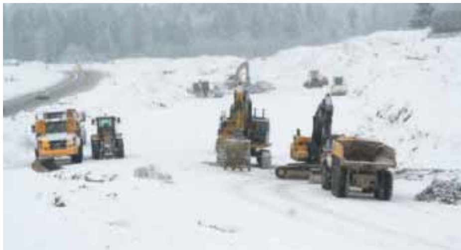
Vinterdrift Nysnø over anleggsområdet gjør det vrient å skaffe visuell oversikt over omfanget av de pågående E16-anleggsarbeidene.
