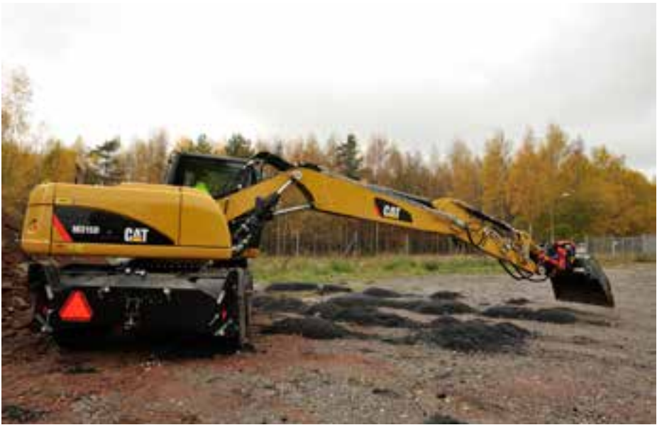
REKKEVIDDE: Med rototilt påmontert skal man være oppmerksom når man utnytter den ekstra rekkevidden i knekkbommen.
