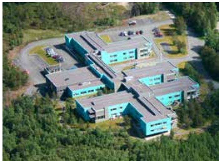
BYGG: Tvisten gjelder grunnarbeider på nye Furumoen sykehjem. (Foto: Ing. S. Laksaa AS)
