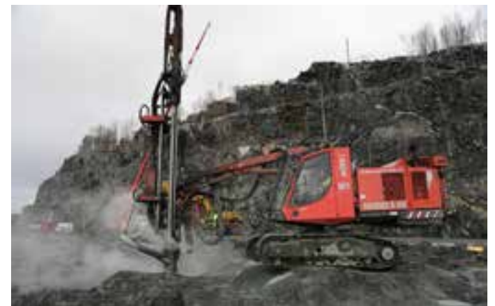
Det bores før det skal sprenges. I bakgrunnen ser man tydelig hvordan Lilandsåsen har blitt sprengt vekk.
