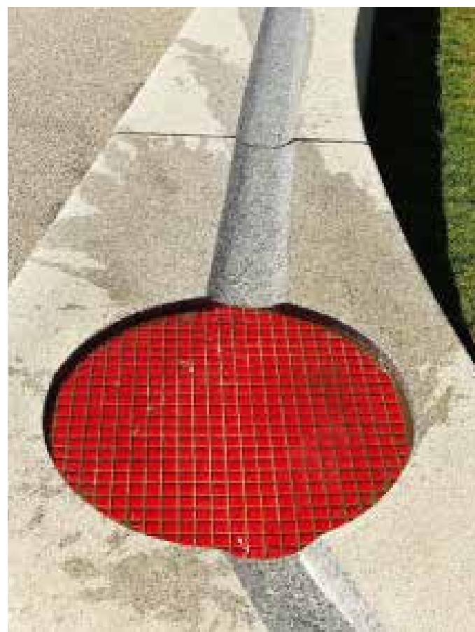
RENNE: Her er en del av vannrenna fra Kina som kom ferdig tilkjørt, nøyaktig laget, nærmest på millimeteren.
