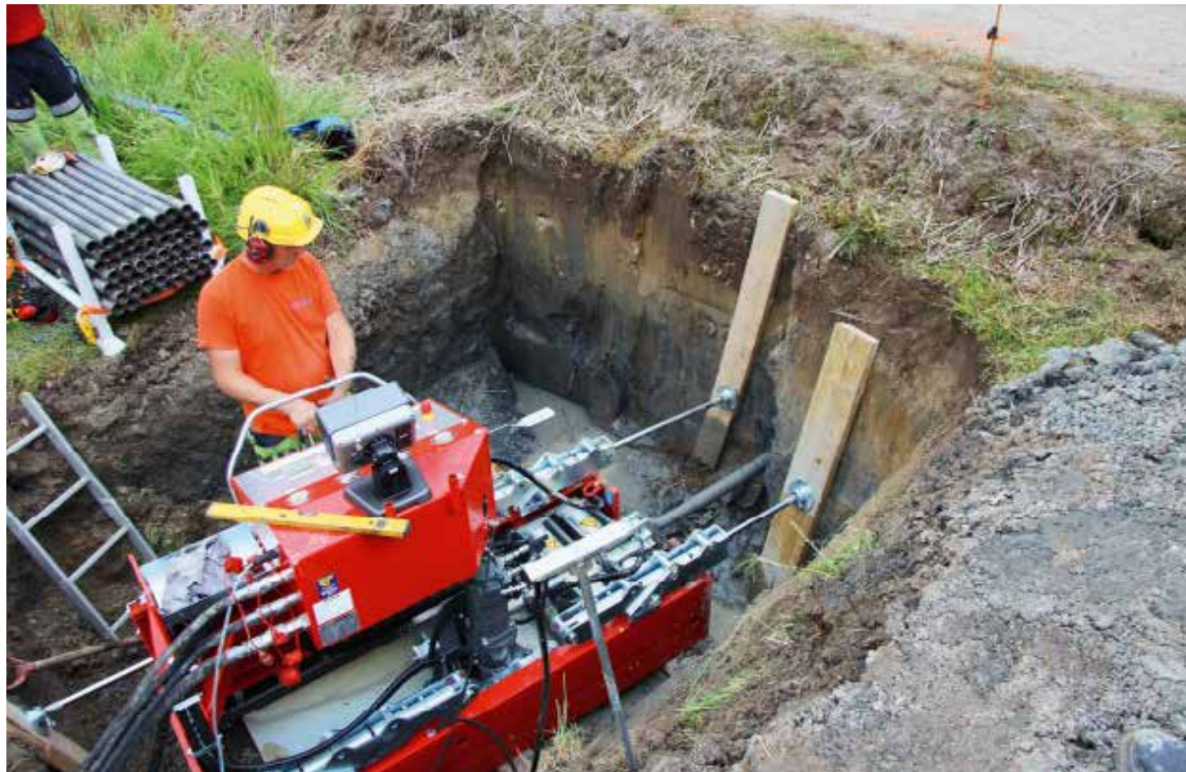
INTERESSERT: Jan Oddvar Smedsrud har investert i eget utstyr for retningsstyrt boring.
